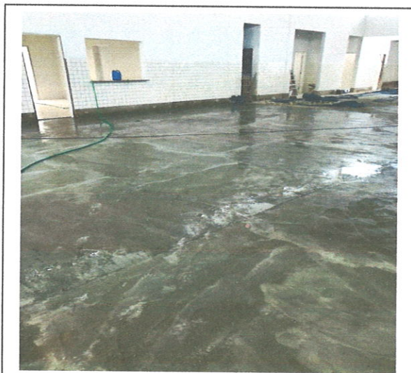
FOTO 107: Piso de alta resistência
