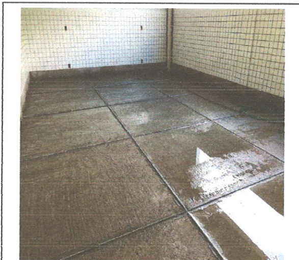
FOTO 115: Piso de alta resistência
