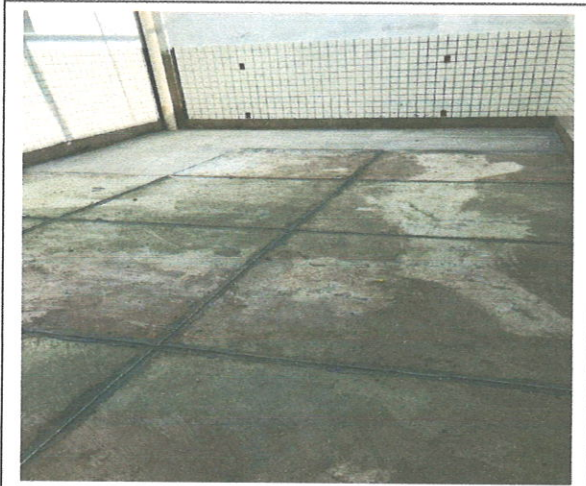
FOTO105: "Filetamento" para piso de alta resistência
