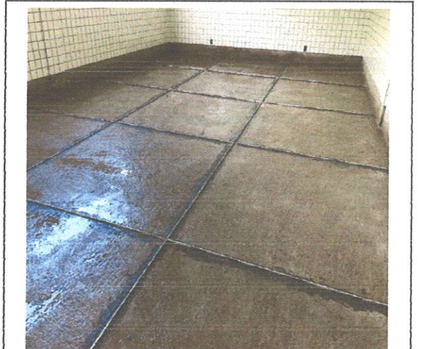
FOTO 114: Piso de alta resistência
