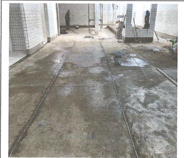
FOTO113: Piso de alta resistência
