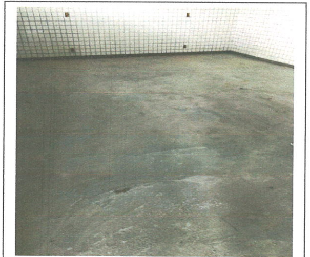
FOTO 106: Piso de alta resistência
